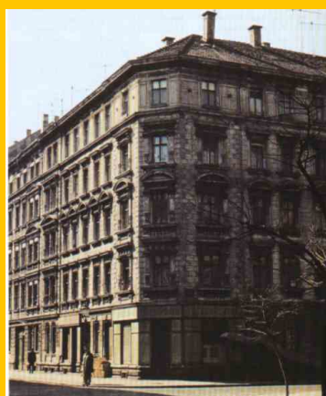
bevor wir mit dem Umbau zum Galerie Hotel Leipziger Hof begannen. (c)Galerie Hotel Leipziger Hof
